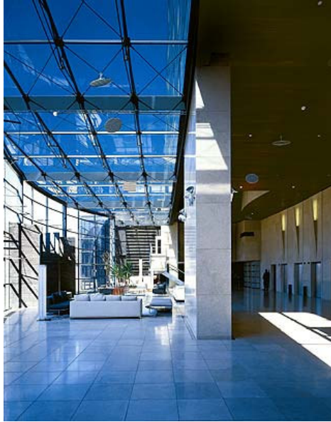
Cobertura de vidro laminado no Hotel Unique em SP. Projeto de Ruy Ohtake.
