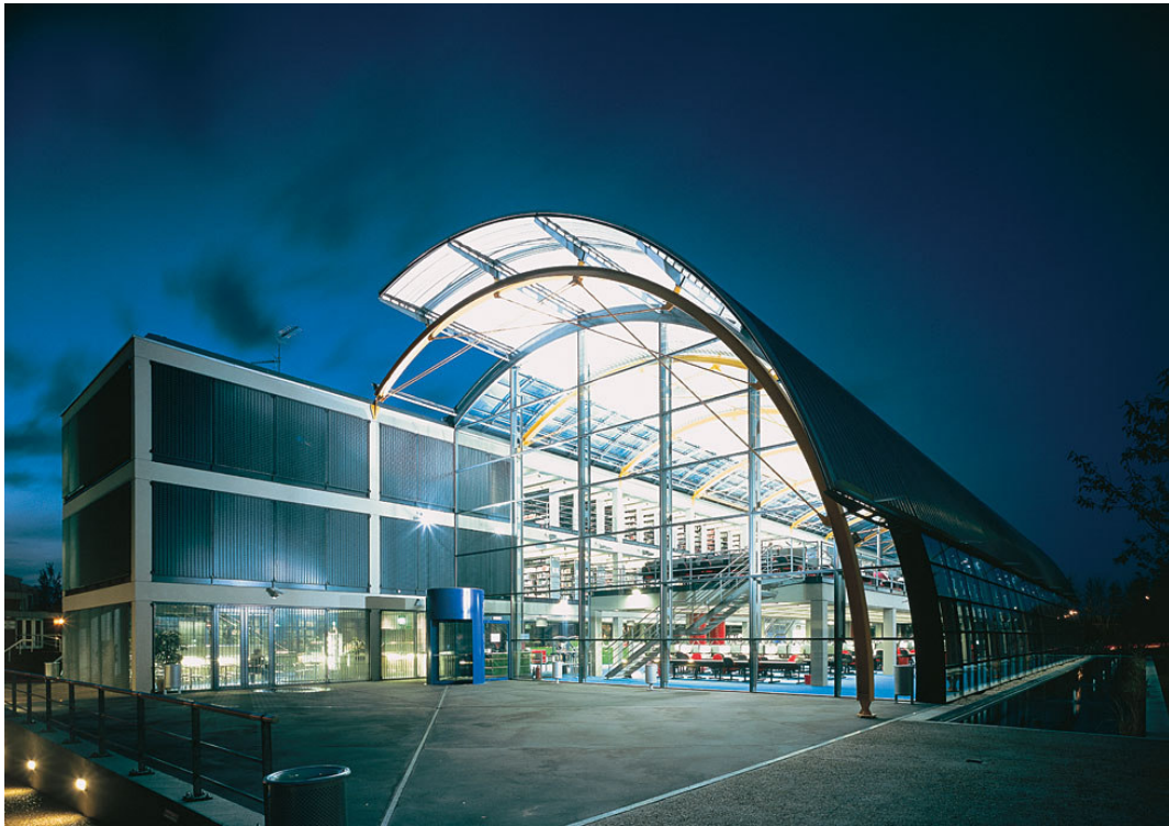
Exemplo de uso de policarbonato na cobertura. Thames Valley University. Projeto: Richard Rodgers.
